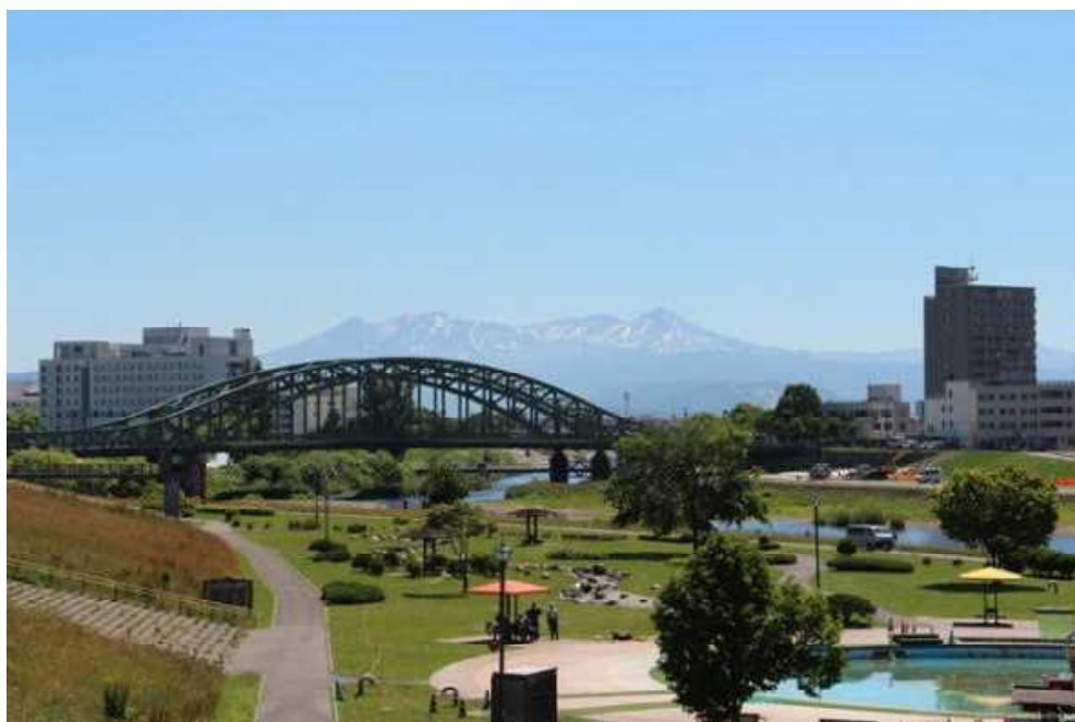
新橋から見た旭橋
